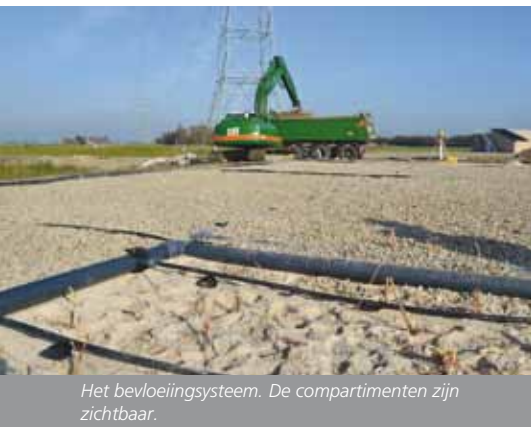
Kiezelbed in de rechthoekige kuil van 10 x 30 x 1,25 meter.
