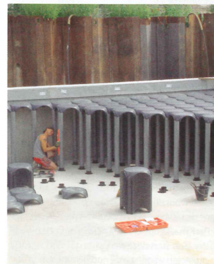
Een watershellsysteem in uitvoering (dit is niet de parkeergarage Kruisplein).
